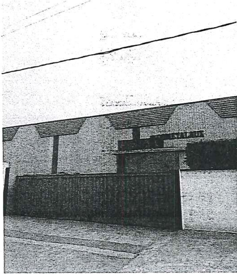
المعمل و المدخل
